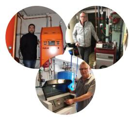
Das Projekt zeigt, dass der Einsatz von HVO in den meisten Fällen ohne aufwendige Umrüstungen an der Anlage möglich ist. Der Betrieb erfolgte problemlos und störungsfrei.
